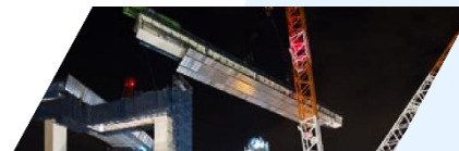
“特殊施工技術”で難工事をクリア
